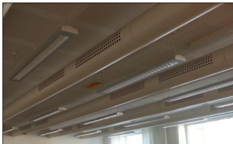
Figur 3.4 Långa tilluftsdon i föreläsningssalar och datorsalar.
